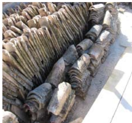
Deposito a cielo aperto dei materiali destinati al reimpiego.
