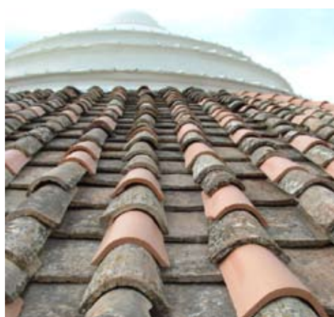
Integrazione di nuovi coppi simili per colore e dimensioni.
