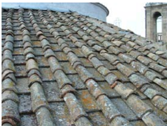
Il vecchio manto di copertura.
