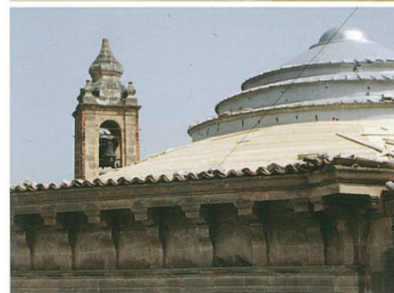
Figura 5.81 Particolari della fase di montaggio della copertura: a) montaggio delle travi lignee e del tavolato; b) tavolato e cornice perimetrale
