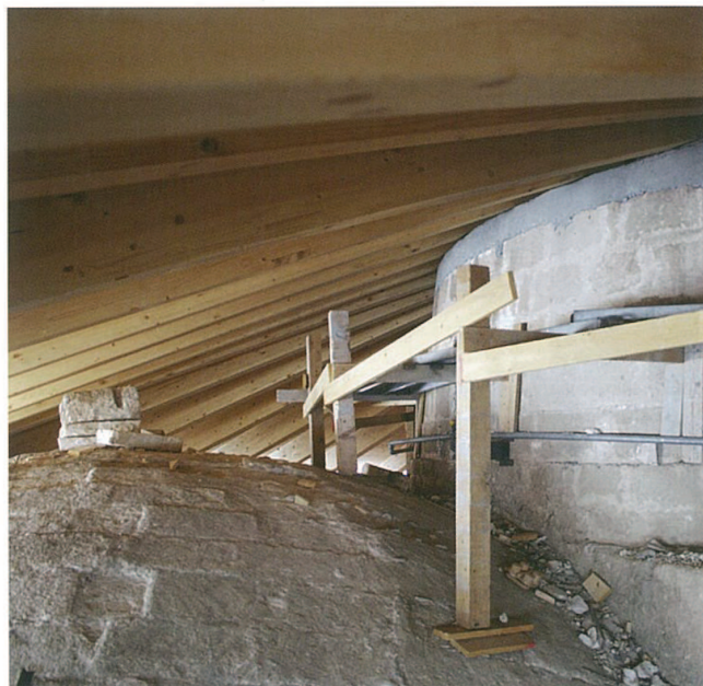
Figura 5.80 La nuova orditura della copertura della chiesa
