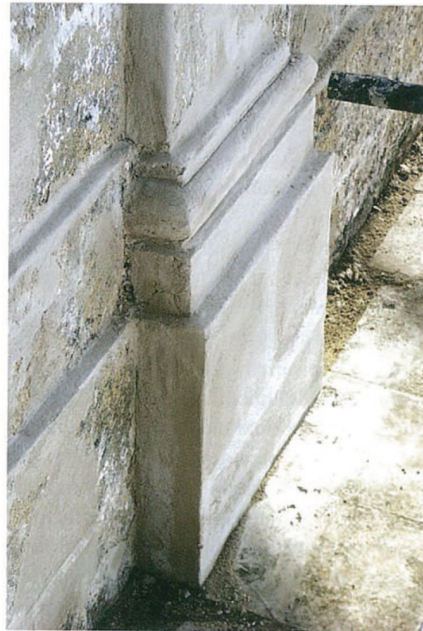
Figura 5.74. Integrazione con malta di calce idraulica della base della lesena del secondo ordine
