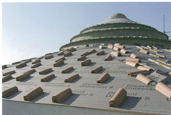
Figura 5.82 Posa in opera di teli impermeabili traspiranti
