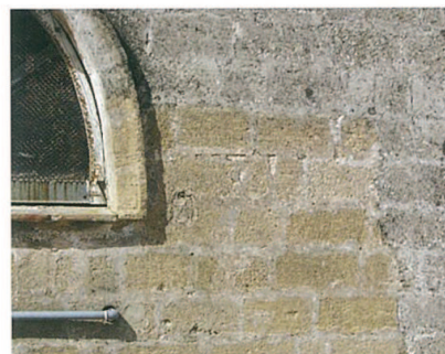
Figura 5.71. Prova di pulitura
