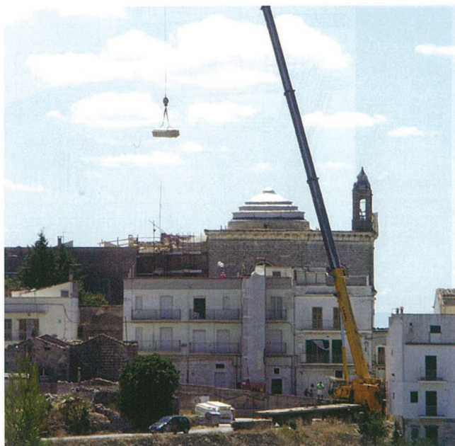
Figura 5.79 Trasferimento delle travi, tramite autogru, sul tetto della chiesa
