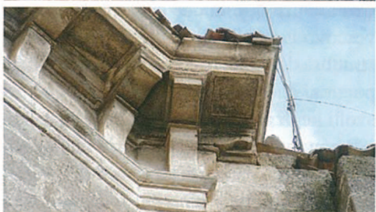
Figura 5.69. Dettagli della cornice dell'ordine superiore: a) si evidenzia che il paramento di tufo calcareo non presentava più il sottile strato di intonaco con cui era originariamente rivestito; b) particolare del terminale
