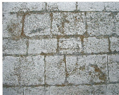
Figura 5.70. I conci lapidei della parte basamentale interessati dalla presenza diffusa di licheni
