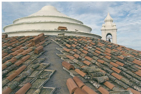
Figura 5.83 Posa in opera del manto di copertura composto da embrici e coppi
