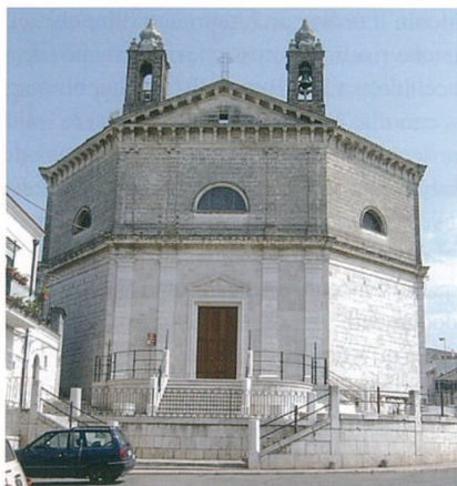
Figura 5.68. La chiesa di San Michele Arcangelo prima del restauro. La graduale disgregazione dell'intonaco aveva causato la perdita dell'originaria uniformità cromatica delle facciate
