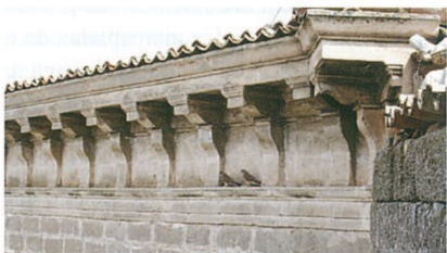
Figura 5.68. La chiesa di San Michele Arcangelo prima del restauro. La graduale disgregazione dell'intonaco aveva causato la perdita dell'originaria uniformità cromatica delle facciate
