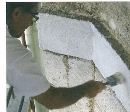
Figura 5.70. I conci lapidei della parte basamentale interessati dalla presenza diffusa di licheni
